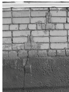
Рис. 12. Трещины на уличном фасаде здания: a – на уровне второго этажа; б – на уровне первого этажа
