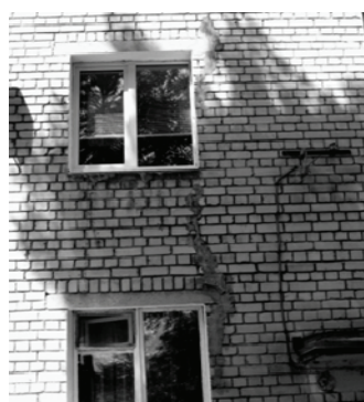
Рис. 10. Трещины в стенах: a – ул. Гоголя, 14; б – ул. Рыльева, 70
