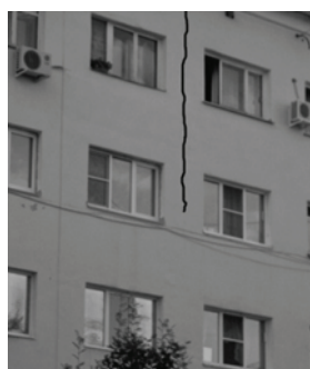
Рис. 11. Дефекты и повреждения дворового фасада дома: a – трещины в стенах; б – раскрытие деформационного шва
