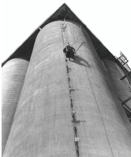
Рис. 2. Монтаж датчиков для замера деформации стенки
