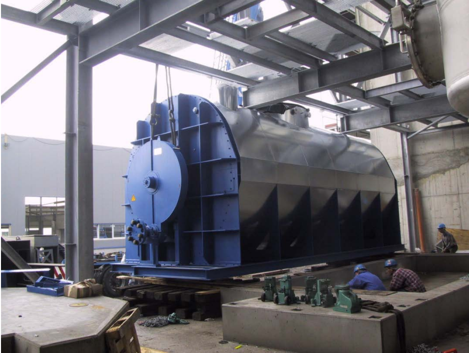
На этом слайде дана фотография роторной трубчатой сушилки Vetter для сушилки послеспиртовой барды в процессе ее монтажа на заводе.
